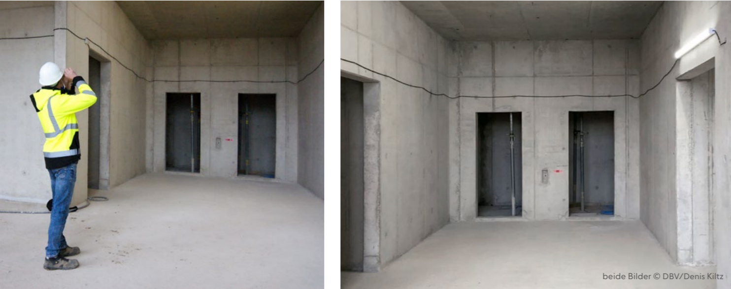
Bild 1.: links: „Remote-Bauberater“ auf der Baustelle – rechts: Sicht des DBV-Bauberaters vom Bauberatungsbüro aus
